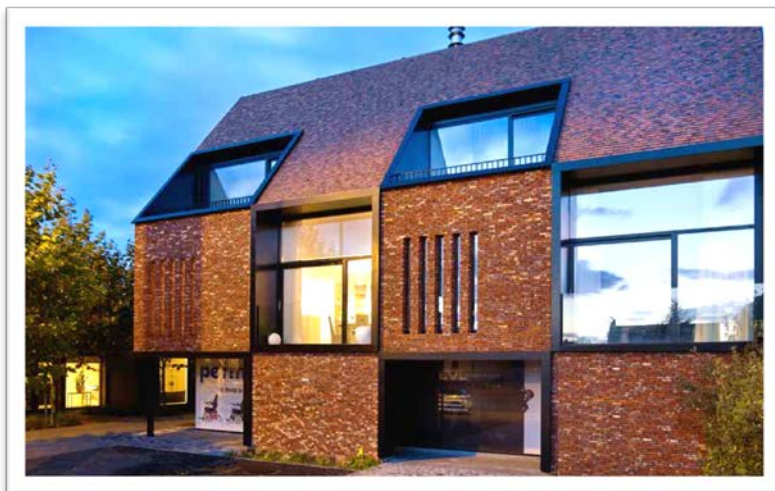
Voorbeeld van een ontwerp waarbij het dakvlak als vijfde gevel ontworpen is
