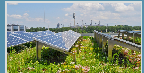
Zonnepanelen met sedumdak
