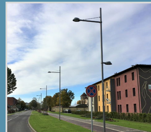
Verlichtingsmasten met armatuur op 2 hoogten
