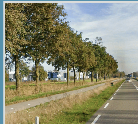
Bomenlaan langs ontsluitingsweg
