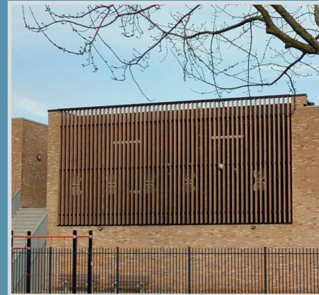
Wegwerking technische installaties
