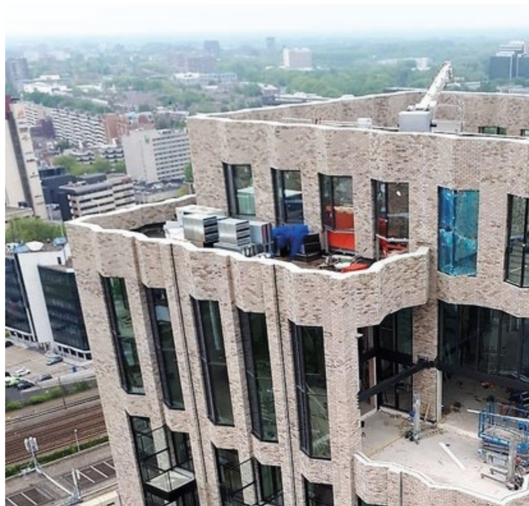
installaties wegwerken achter doorlopende geveldelen
