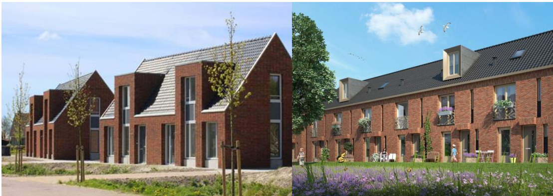
Twee-onder-één-kapwoningen en een rijtje huizen met een zadeldak, alle met eenvoudige, enkelvoudige hoofdvorm en sobere architectuur
