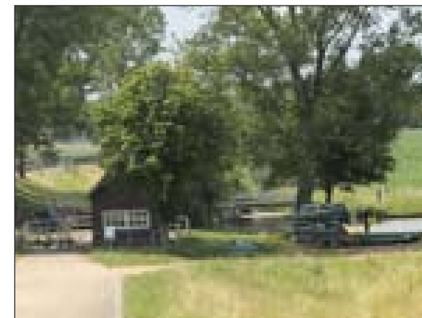
Stuwgebouw aan de Rheezerweg
