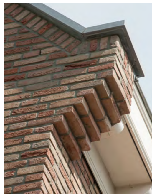
voorbeeld detail aansluiting dakgoot-kopgevel
