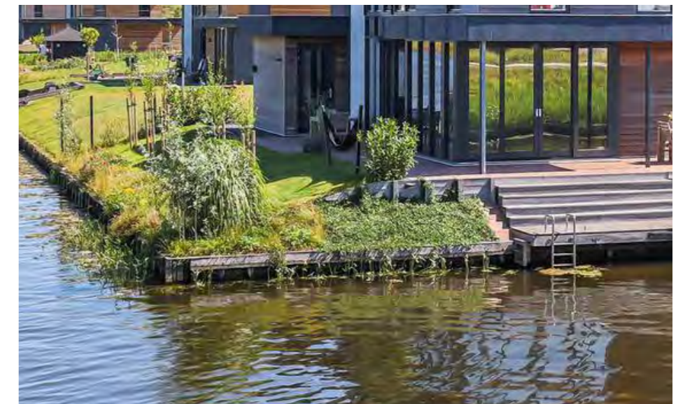
houten trap op talud
