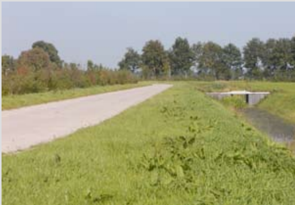
Bestaande watergang langs verlengde Hardenbergerveldweg
