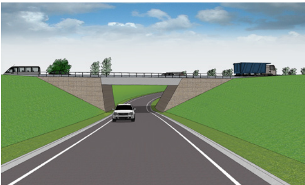
2. Duidelijk verschil tussen binnen- en buitenbocht in helling talud en wanden landhoofd
