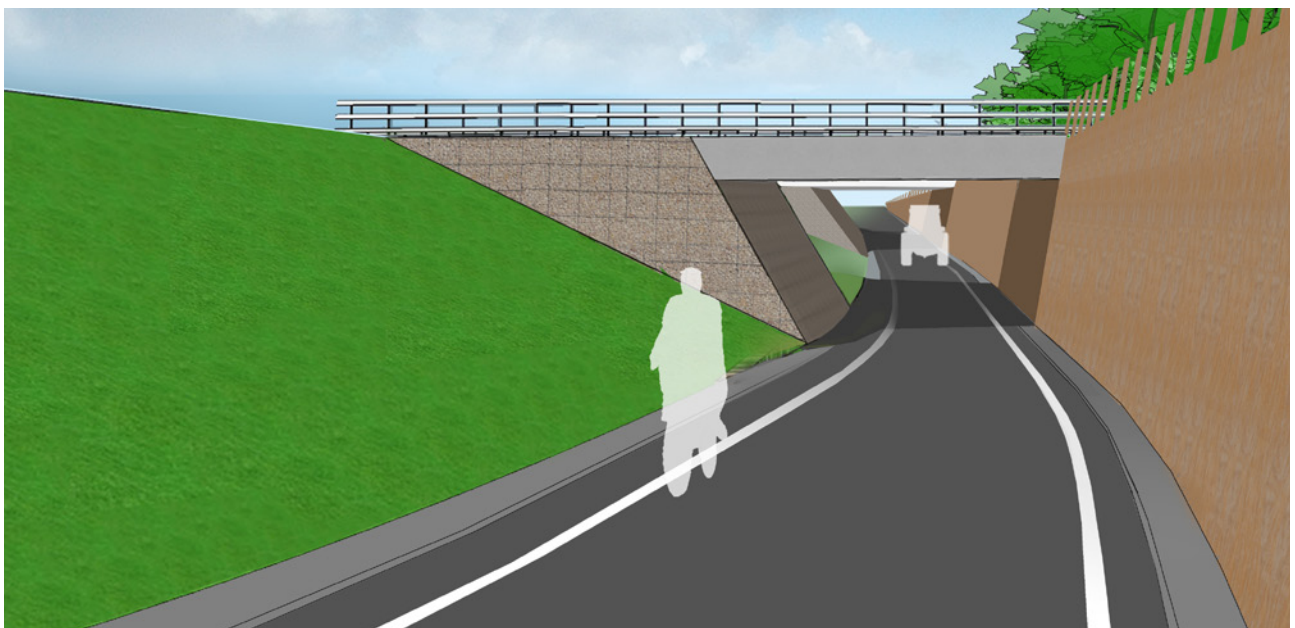
Asymmetrisch profiel, links talud 1:2 met bloemrijk gras, rechts keerwand met natuurlijke uitstraling, conform eisen. Rechtsboven is de monumentale bomenrand zichtbaar. Door het scheiden van de dekken van N34 en Scheerseweg is er betere lichtinval in de tunnel.
