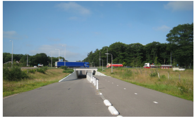
Tunnel Witte Paal
