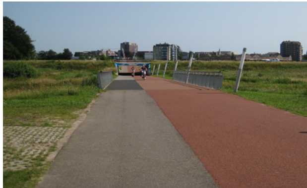
Fietspad Hardenberg onder N34 door
