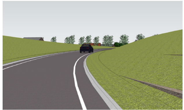
3. Uitrijden tunnel richting noorden
