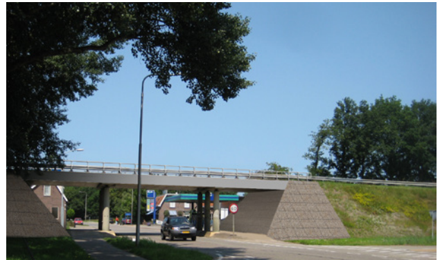
De Vaart na verbeteringslag ruimtelijke kwaliteit: landhoofden van schanskorven, aanpassing rand brugdek en valbeveiliging conform beeldkwaliteit kunstwerken N34 Witte Paal-Drentse grens.
