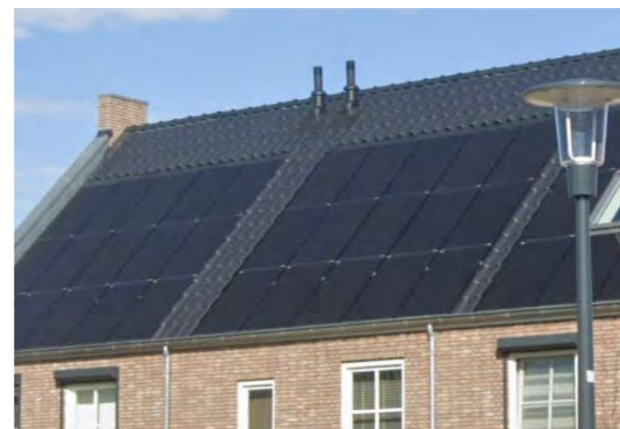
zonnepanelen in grote vlakken en sluiten aan op de pankleur ('in daks' of all black)
