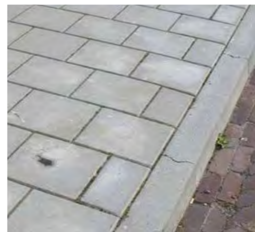
Betontegel halfsteensverband
