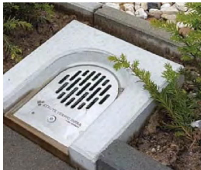
hemelwaterafvoer via uitstroomtegel
