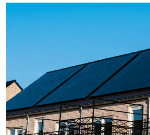
zonnepanelen in grote vlakken en sluiten aan op de pankleur ('in daks' of all black)
