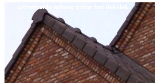
rollaag en gemetseld oor onder het dakvlak
