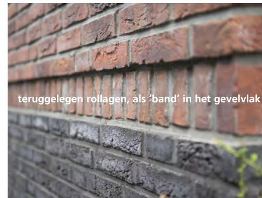
bakstenen in een afwijkende kleur, als speklaag en als accentsteen
