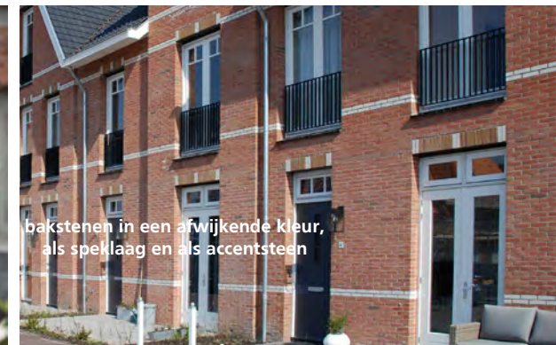
teruggelegen rollagen, als ‘band’ in het gevelvlak
