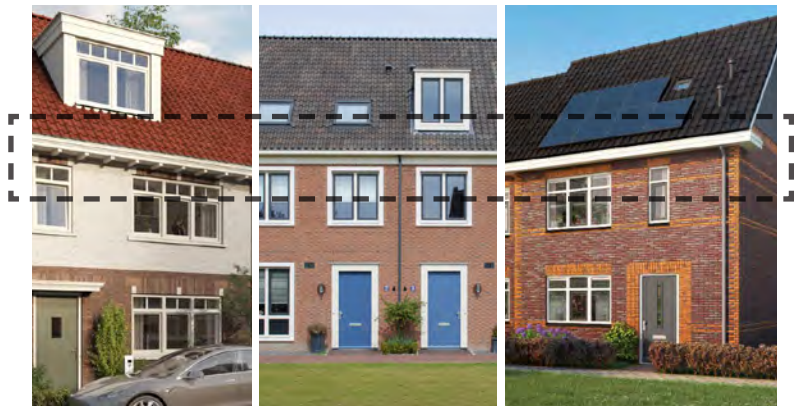
een uitkragende daklijst en/of goot als beeldbepalend detail
