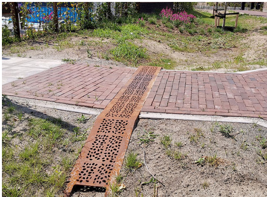
lijngoot (waar nodig), cortenstaal met motief
