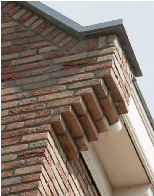
voorbeeld detail aansluiting dakgoot-kopgevel
