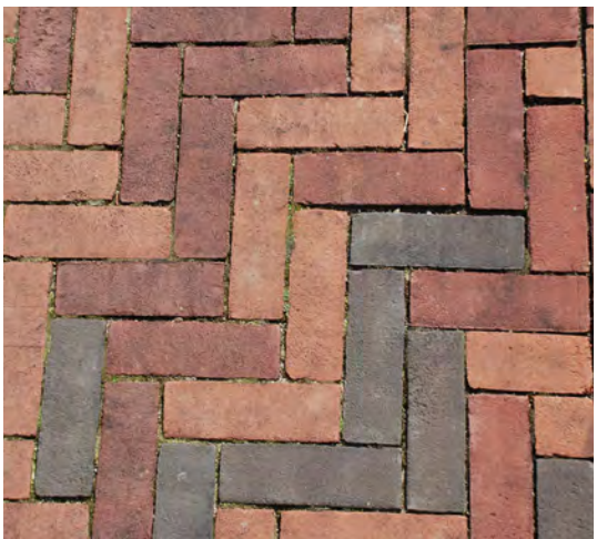
Betonklinker Keiformaat roodbruin elleboogverband (kleur aansluitend op rijbaan)
