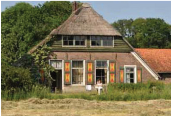
bestaande hoeve als referentie
