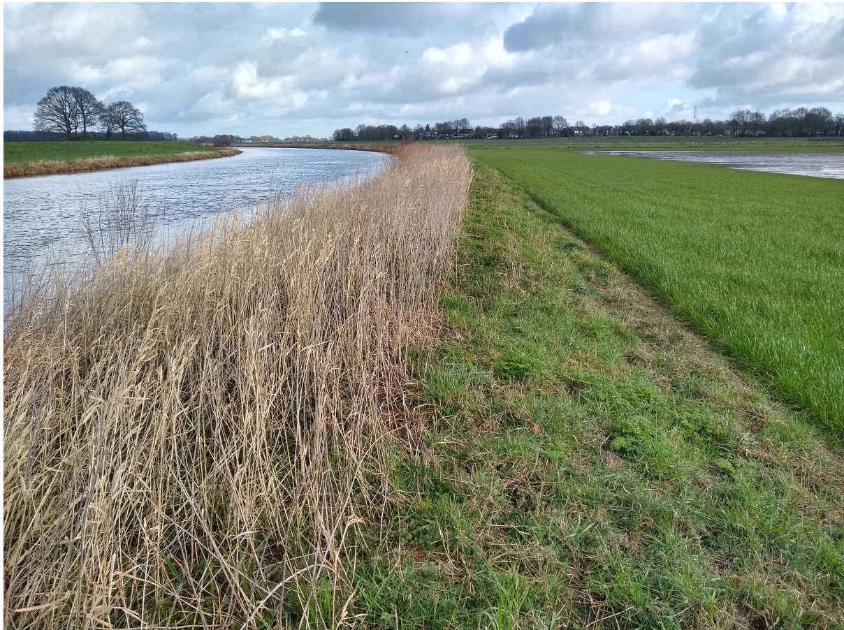
Figuur 6: De vecht in stroomopwaartse richting gezien, vanaf de J.C. Kellerlaan, met in het midden de zandwerende kade en rechts grasland waarop na inundatie nog water zichtbaar is.
