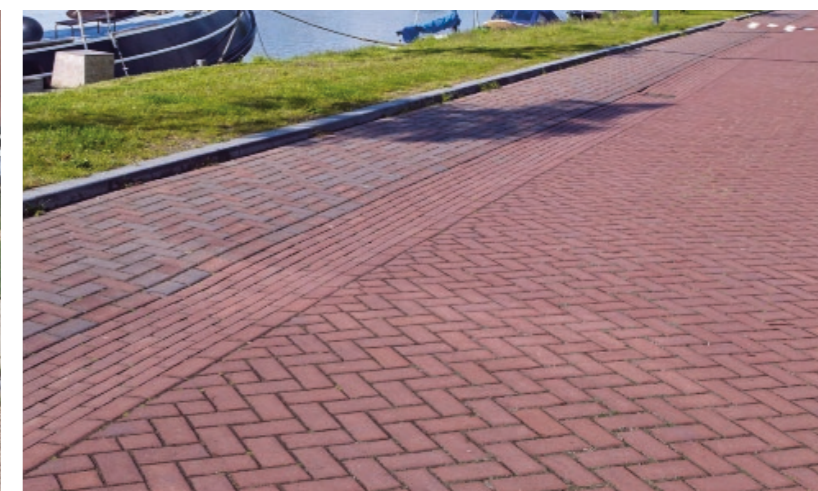
impressie materiaalgebruik gebakken klinkers
