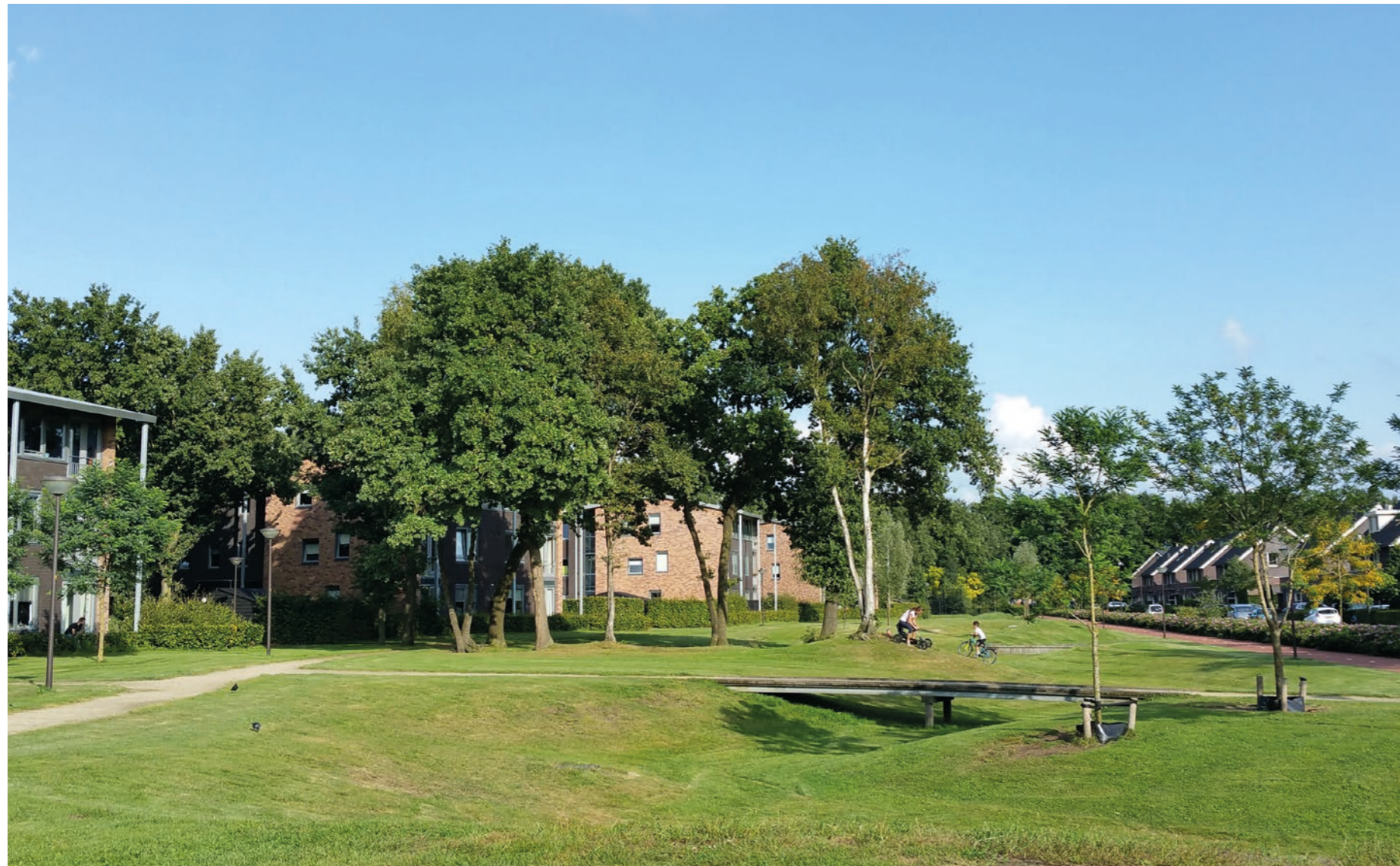
Wadi's, voor de opvang van regenwater, maken onderdeel uit van de glooiingen in het park. Door middel van een vlonder kan het pad horizontaal doorlopen (minder validen) en ontstaat tevens een speciale plek in het park
