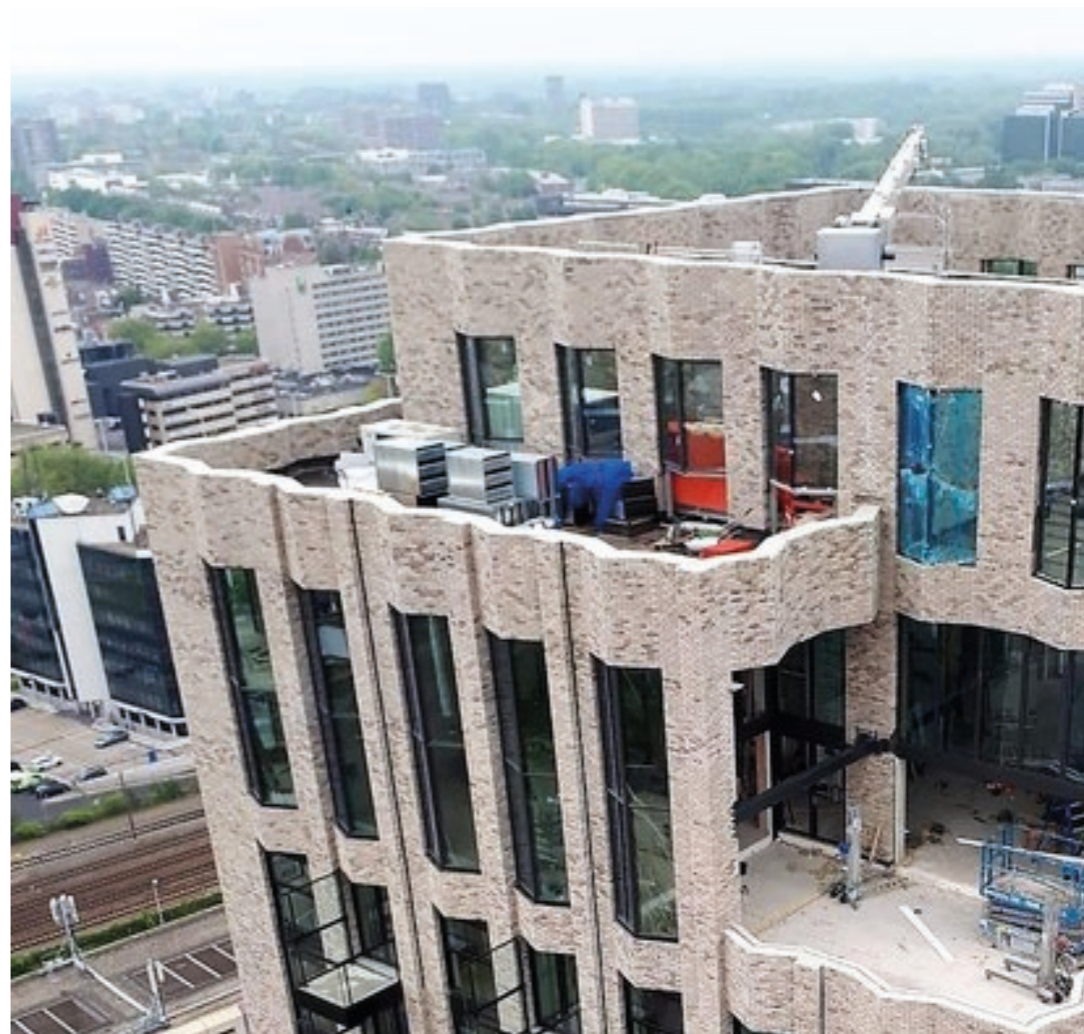
installaties wegwerken achter doorlopende geveldelen
