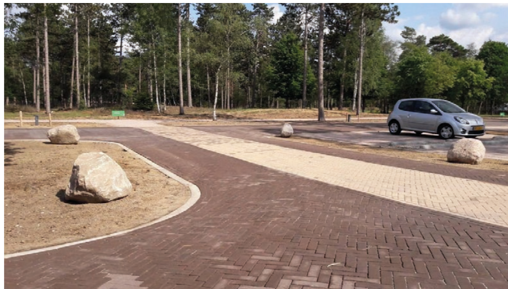
Keien als borderbescherming op wildparkeren in het Vechtpark
