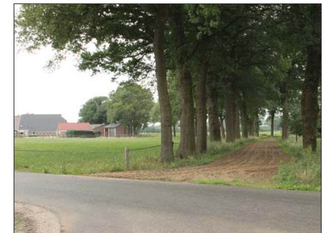
Enkele onverharde wegen
